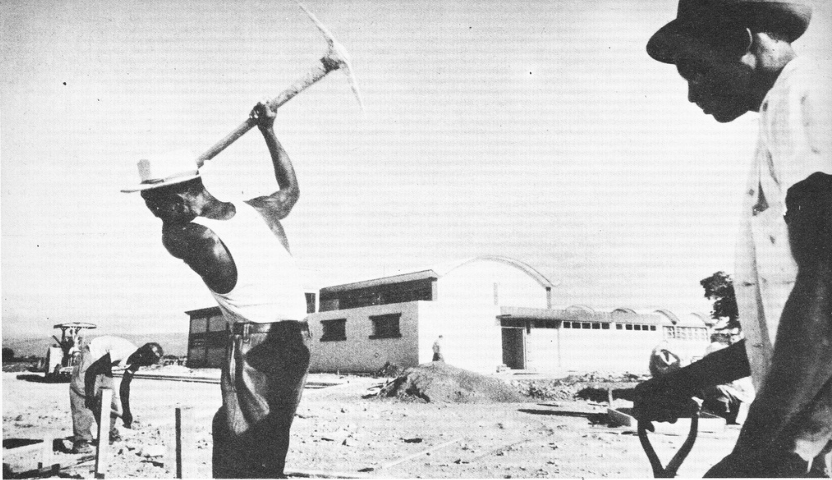
Obreros cubanos laboran en la ampliación de la Fábrica de Picos y Palas, en Jamaica, Guantánamo. Vivimos la era de la industrialización cubana.
